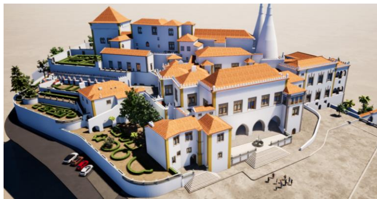
Figura 2.2 – Modelo H-BIM do Palácio Nacional de Sintra, no programa TwinMotion (Bento et al., 2020)
