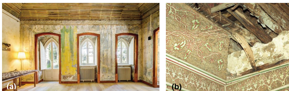
Figura 5.8 - Sala de Jantar com estrutura do teto visível, destacando-se (a) o fasquiado e (b) a cambota (créditos PSML)
