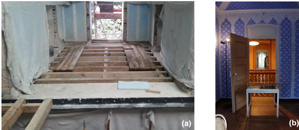
Figura 3.13 - Pavimento de madeira do Quarto das Rendas com: (a) vigas e tarugos à vista e (b) soalho à inglesa
