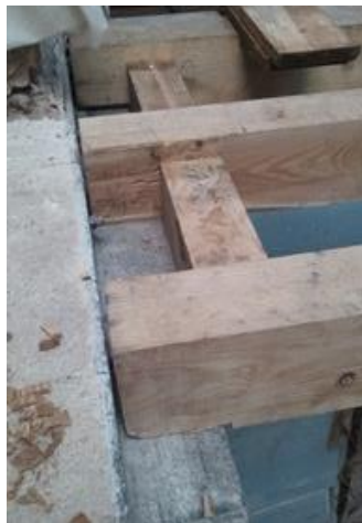
Figura 3.14 – Entregas dos vigamentos de madeira nos perfis metálicos (créditos PSML)
