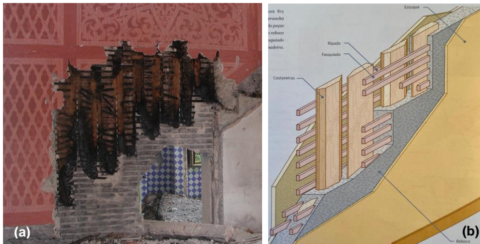
Figura 3.7 – (a) Parede de tabique simples entre o átrio das escadas e a cozinha, após o incêndio (créditos PSML) e (b) desenho esquemático da mesma (Appleton, 2011)
