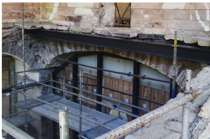
Figura 3.6 – Restauro das paredes de frontal, entre a Sala das Heras e o Vestíbulo Nobre (créditos PSML)
